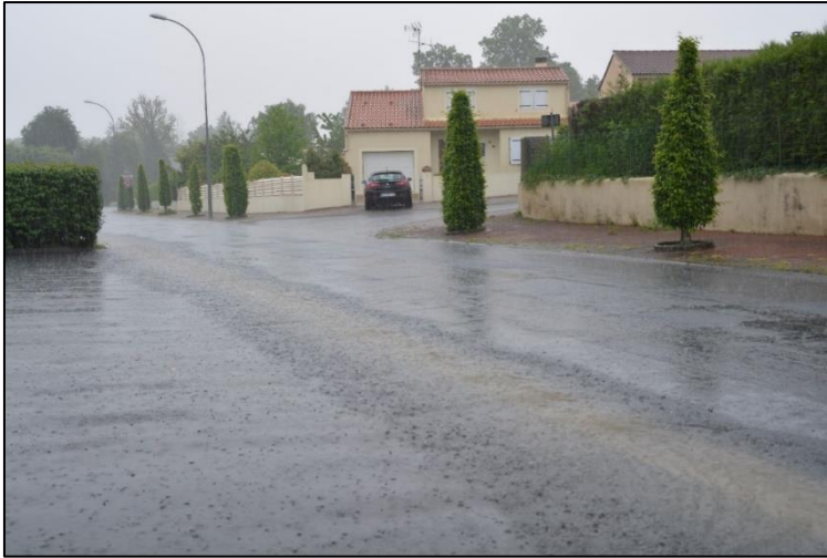
Ruissellement dans l'allée de la Vénérie à Mouilleron-le-Captif
